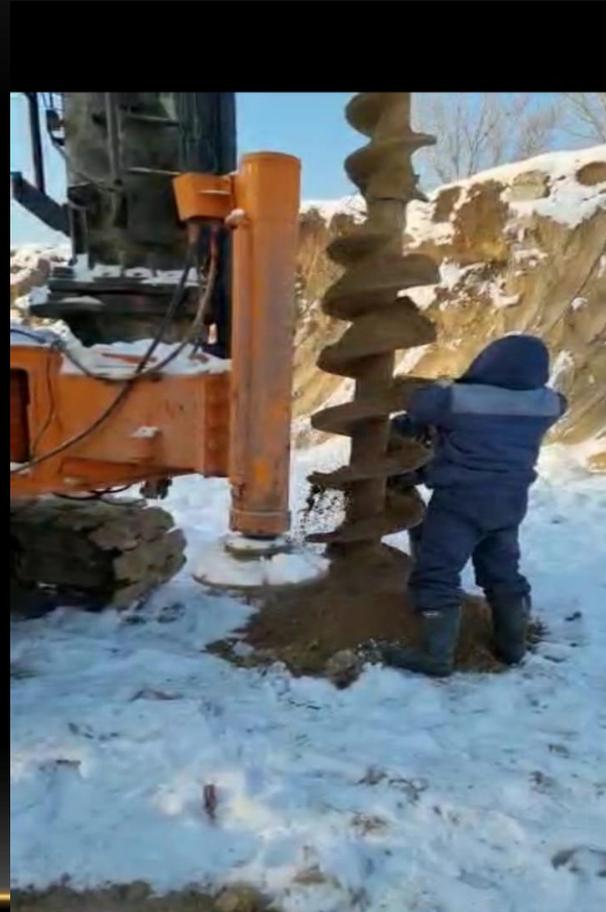
РЕКОНСТРУКЦИЯ ГКП НА ПХВ «АЛМАТИНСКАЯ МНОГОПРОФИЛЬНАЯ КЛИНИЧЕСКАЯ БОЛЬНИЦА" СО СТРОИТЕЛЬСТВОМ ПРИСТРОЕК ЛЕЧЕБНЫХ КОРПУСОВ НА 360 КОЕК СО СНОСОМ СУЩЕСТВУЮЩИХ СТРОЕНИЙ ПО АДРЕСУ:РК, Г.АЛМАТЫ, УЛ.ДЕМЧЕНКО 83-Б.» КОМПЛЕКС РАБОТ ПО БУРЕНИЮ СВАЙ, ПО УСТРОЙСТВУ ИСПЫТАТЕЛЬНОГО СТЭНДА И СТАТИЧЕСКОГО ИСПЫТАНИЯ. 2023ГОД
