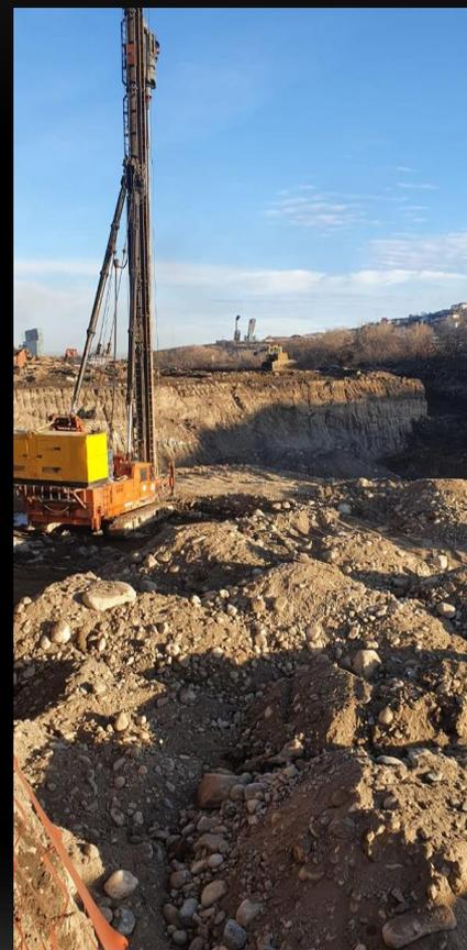
ОБЪЕКТ: «МНОГОФУНКЦИОНАЛЬНЫЙ АВТОЦЕНТР «МУСАР»- РАБОТЫ ПО БУРЕНИЮ СКВАЖИН ПОД СВАИ МЕТОДОМ РАСКАТКИ С УСТРОЙСТВОМ БЕТОНИРОВАНИЯ.2021ГОД
