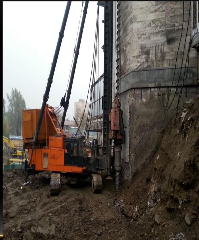
ОБЪЕКТ: «ВОССТАНОВЛЕНИЕ ВЕРТИКАЛЬНОСТИ ДОМОВ №1/179, 1/180, 1/160, 1/161, 1/165, 1/167 В МКР.ЗЕРДЕЛИ, АЛАТАУСКОГО РАЙОНА, Г.АЛМАТЫ.» - УСТРОЙСТВО ПРОТИВОФИЛЬТРАЦИОННОГО ЭКРАНА (ИНЪЕКЦИОННЫЕ СВАИ), УСТРОЙСТВО БУРОНАБИВНЫХ СВАЙ, ЗАКРЕПЛЕНИЕ ДОМА». 2020ГОД
