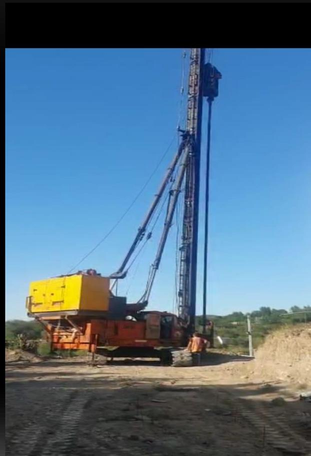
ОБЪЕКТ: «СТРОИТЕЛЬСТВО МНОГОЭТАЖНЫХ ЖИЛЫХ ДОМОВ «СОФИЯ» - РАБОТЫ ПО УСТРОЙСТВУ СВАЙ МЕТОДОМ «МОНОJET».2021ГОД
