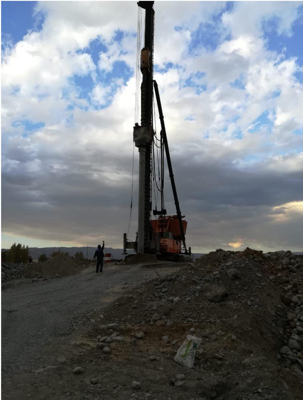
2. Nippon Sharyo DHP-80. Шнековое бурение (непрерывный шнек), бурение свай методом раскатки. Диаметры бурения от 300 до 600 мм, глубина бурения до 25 метров
