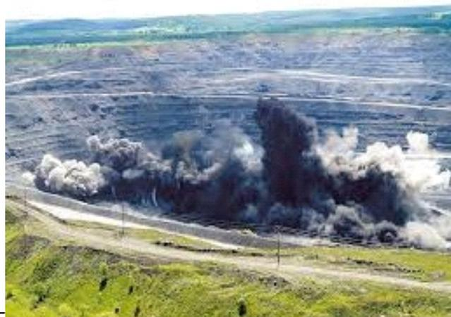
При проведении этих работ нашими работниками проводятся контролируемые взрывы породы, совместные с интенсивным бурением. Таким образом, становится возможным корректировать земной рельеф на избранной вами территории для дальнейшего строительства. Также, буровзрывные работы широко используются в геологических изысканиях, так как позволяют обнаруживать более глубоко расположенные месторождения для дальнейшего исследования.
