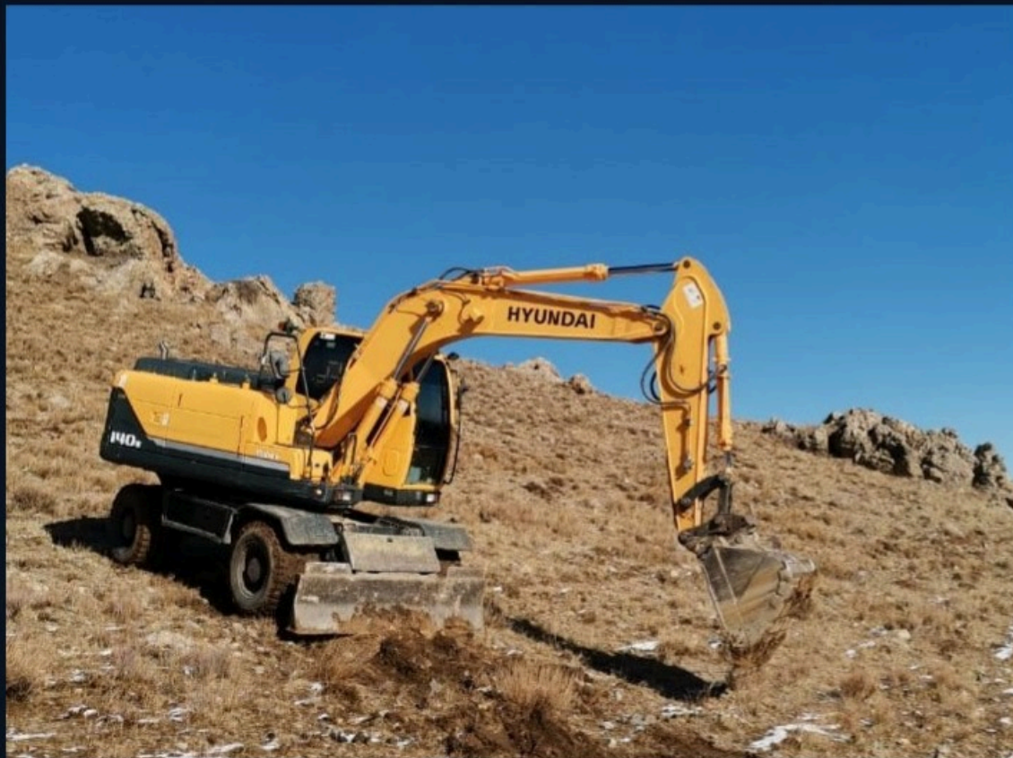
Земляные работы с применением экскаватора
